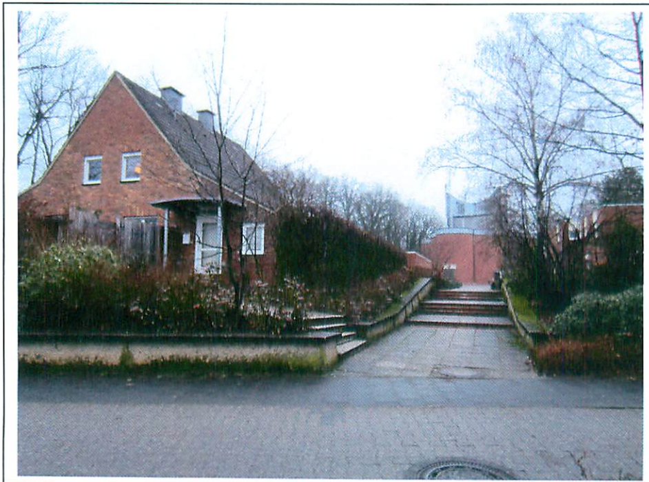
Blick über die Gesamtanlage von der Einener Straße: Autofreie Zuwegung zur Kirche, rechts angeschnitten das Pfarrhaus (2012).
